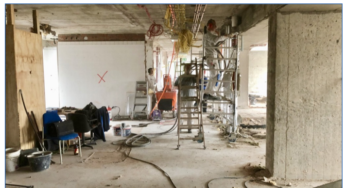
Bauarbeiten auf der ehemaligen Station C21 im 2. Stock der Kopfklinik
